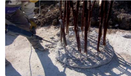
Poistetaan ulkonemat, puhdistetaan paalun pää
