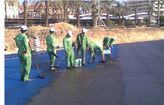
Vedeneristys KÖSTER Deuxan:lla
