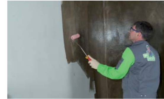
Alustan pohjustuksen jälkeen, viisteet asennetaan seinä/lattia liitokseen.
