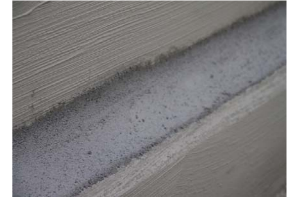
2. Viiste asennettu KÖSTER WP laastilla
