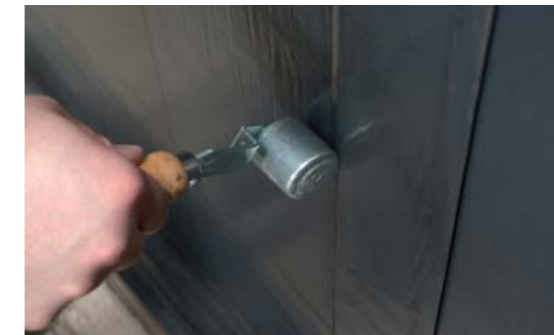
Käytä rullainta voimakkaasti painaen päällyste alustaan.
