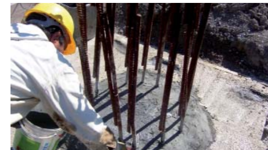
Paalu vedeneristetään KÖSTER NB 1 Harmaalla
