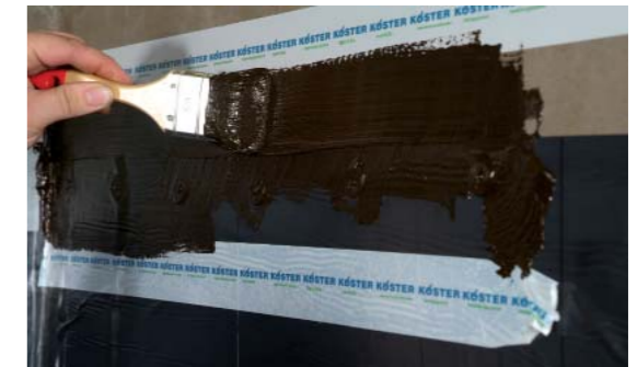
Päällysteen reunat tiivistetään KÖSTER KBE Neste-kalvolla.
