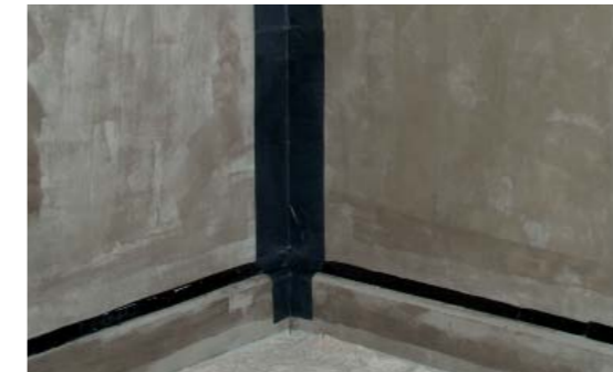
Tämän jälkeen päällyste asennetaan sisä- ja ulkokulmiin.
