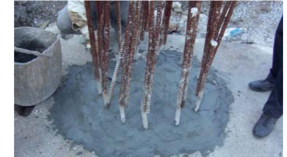
Asennetaan viiste ja tasoitetaan alue KÖSTER Korjauslaastilla
