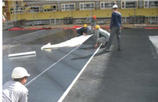
Vedeneristys KÖSTER KSK päällysteillä
