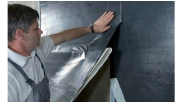
Alue vedeneristetään päällysteellä. Päällysteet tulee limittää n. 10 cm.
