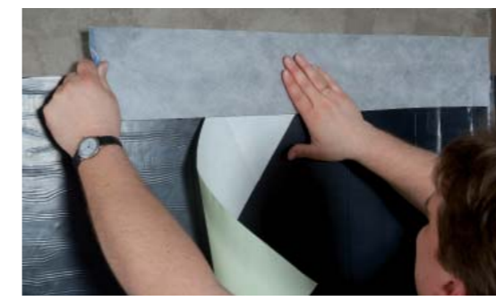
Jos erillistä vedeneristyspohjaa ei ole asennettu, ylemmän vedeneristyskerroksen reuna on yletyttävä 30 cm maan yläpuolelle. Kun halutaan saavuttaa visuaalisesti miellyttävä lopputulos, ylempi kalvon reuna voidaan peittää itseliimautuvalla KÖSTER Butyyli-Fix-Kuitunauhalla. Tämä nauha voidaan peittää rappauksella.
