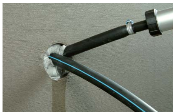
Tämän jälkeen aukko täytetään KÖSTER KB-Flex 200:lla käyttäen KÖSTER Käsipistoolia.
