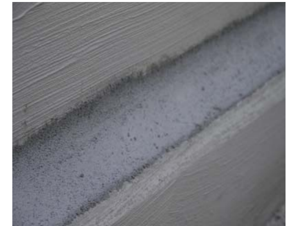
Kovera viiste seinä/lattia liitoksessa tehtynä KÖSTER Korjauslaastilla
