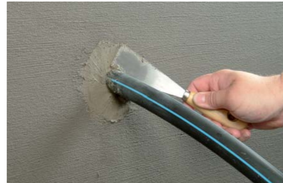
Putken läpivienti on nyt vedeneristetty. Tarkoituksena on suojata vedeneristystä, siksi alue putken tai kaapelin ympärillä tukitaan KÖSTER KB-Fix 5:lla.
