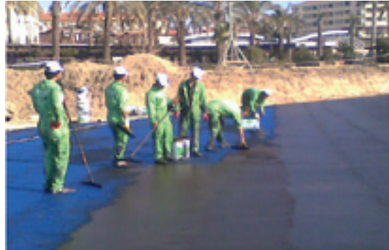
Vedeneristys KÖSTER Deuxan®:lla
