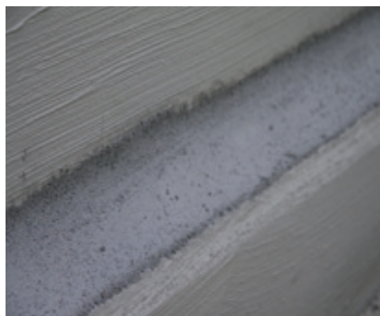
Kovera viiste seinä/lattia liitoksessa tehtynä KÖSTER Korjauslaastilla
