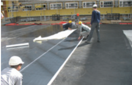
Vedeneristys KÖSTER KSK päällysteillä
