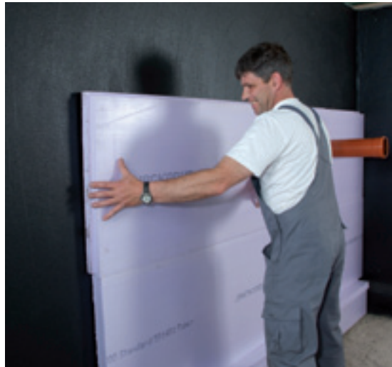
XPS levyt pisteliimattu KÖSTER Deuxan®:lla
