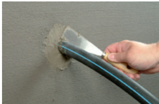
Putken läpivienni on nyt vedeneristetty. Tarkoituksena on suojata vedeneristystä, siksi alue putken tai kaapelin ympärillä tukitaan KÖSTER KB-Fix 5:lla.
