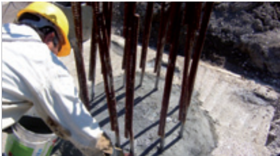
Paalu vedeneristetään KÖSTER NB 1 Harmaalla
