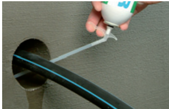
Polyuretaanivaahtoa ruiskutetaan sisään aukkoon vahvisteeksi KÖSTER KB-Flex 200:lle.
