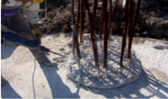
Poistetaan ulkonemat, puhdistetaan paalun pää
