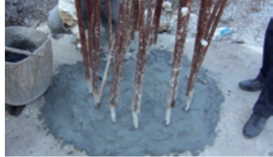
Asennetaan viiste ja tasoitetaan alue KÖSTER Korjauslaastilla
